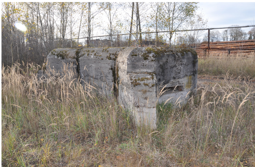
Dwustrzelnicowy schron bojowy do ognia bocznego w Rozprzy
