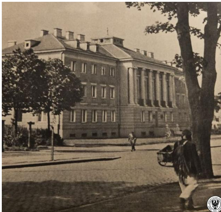
Fot. 5. Siedziba KM PZPR w Opolu w latach 1954–1956, następnie gmach KW (1956–1990). Aktualnie budynek Wydziału Ekonomicznego Uniwersytetu Opolskiego.
